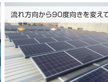
大波ストレートをカバーした屋根
